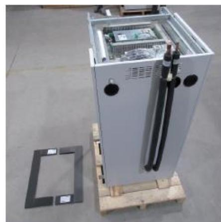
Umiestnenie izolačnej protihlukovej podložky
