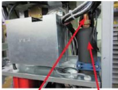
spoločné napájacie potrubie elektrický ohrievač
